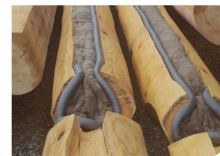
IZOLOVÁNÍ SRUBOVÝCH KULATIN
