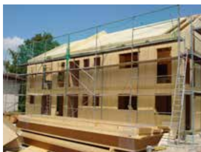
Připravené střešní krokve STEICO joist čekají na montáž na střechu.
