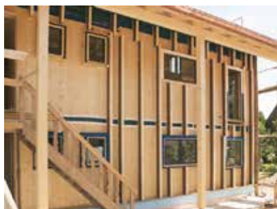
Vytvoření izolační roviny na stěně z masivního dřeva pomocí STEICO wall jako smyku odolné spodní konstrukce.
