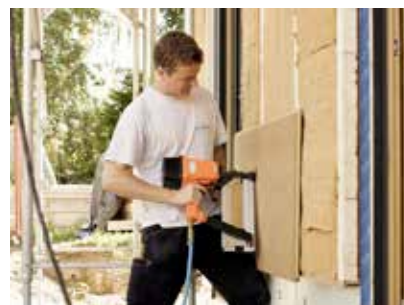
Izolace stěnové dutiny pomocí STEICO flex . Ukončení prostřednictvím STEICO universal tvoří druhou vodoodpudivou vrstvu pod obkladem z modřínových palubek.
