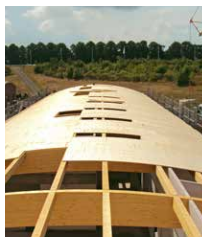
Příklad: ztužující střešní opláštění s vysokou zatížitelností v komerční oblasti a výstavbě hal
