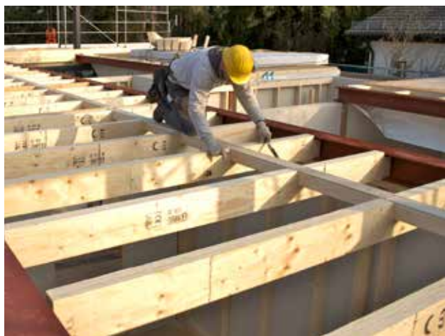
STEICO LVL R u nosné konstrukce stropu
