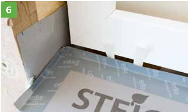
6 Montáž izolačního klínu STEICOfix. TIP: Ohněte krycí papír nahoru, později ho tak lze snadněji odstranit.
