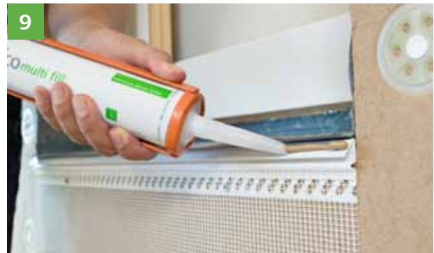
9 Přesah fólie se pomocí tmelu STEICOmulti fill slepí s okapničkou atikového profilu.
