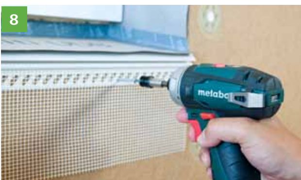
8 Pro bezpečné napojení omítky se pod izolační klín STEICOfix namontuje atikový profil (nerezové šrouby nebo spony).
