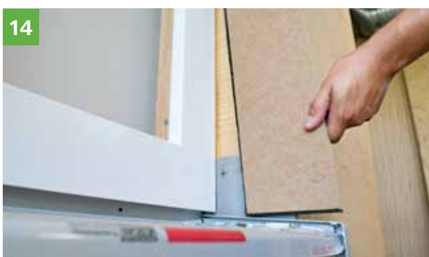
14 Vsazení desky pro ostění tak, aby lícovala s vnější hranou fasády VKZS. TIP: Počítejte s případným rozšířením okenního rámu.
