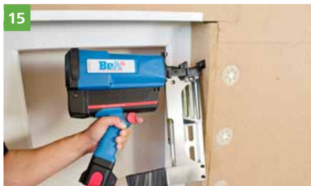
15 Připevnění desky pro ostění pomocí širokých spon nebo nerezových šroubů pro nerušené vytvrzení tmelu STEICO multi fill .
