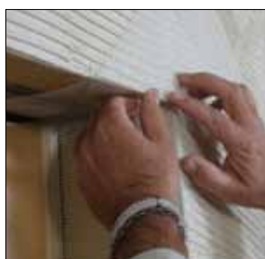
rohový úhelník pro vyztužení v oblasti překladu
