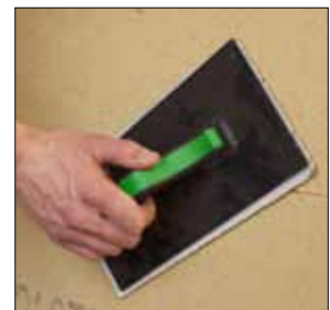
přebroušení přesazení desek
