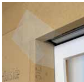
rohový úhelník pro vyztužení v oblasti překladu
