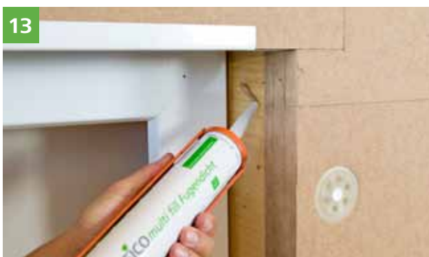
13 Nanesení housenek tmelu STEICO multi fill do dřevěné rámové konstrukce, aby bylo zaručeno bezpečné upevnění desky pro ostění.
