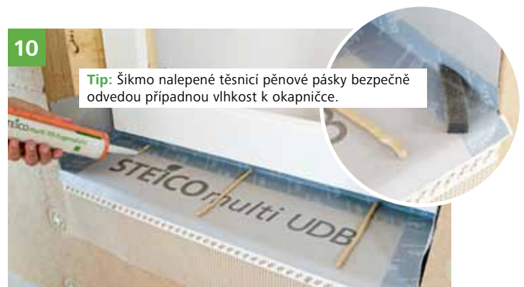
10 Nanesení housenek tmelu STEICOmulti fill e ≤ 30 cm pro pružné upevnění parapetu.
