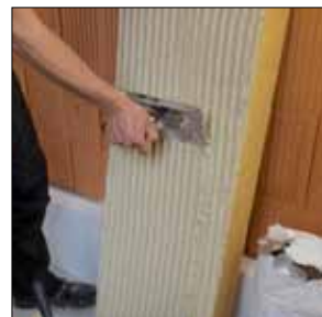
Lepení izolační desky na rovný podklad metodou celoplošného lepení
