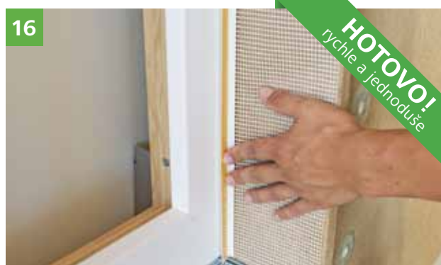
16 Montáž vhodné omítkové lišty pro bezpečné zakončení omítky - práce na VKZS mohou pokračovat.
