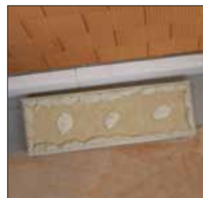
Lepení izolační desky na nerovný podklad takzvanou „bodovou metodou“
