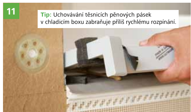
11 Montáž parapetu. TIP: Zadní ohyb plechu se nachází v příslušné drážce okna, přední ohyb se nachází ve vzdálenosti ≥ 3 cm od omítky.
