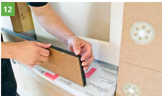
12 Montáž desky pro ostění. Ochrana proti dešti nalepením těsnící pěnové pásky na přední a čelní spodní hranu izolační desky ostění.
