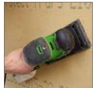
přebroušení přesazení desek
