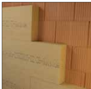
Přesazení maloformátových desek s tupými hranami.
